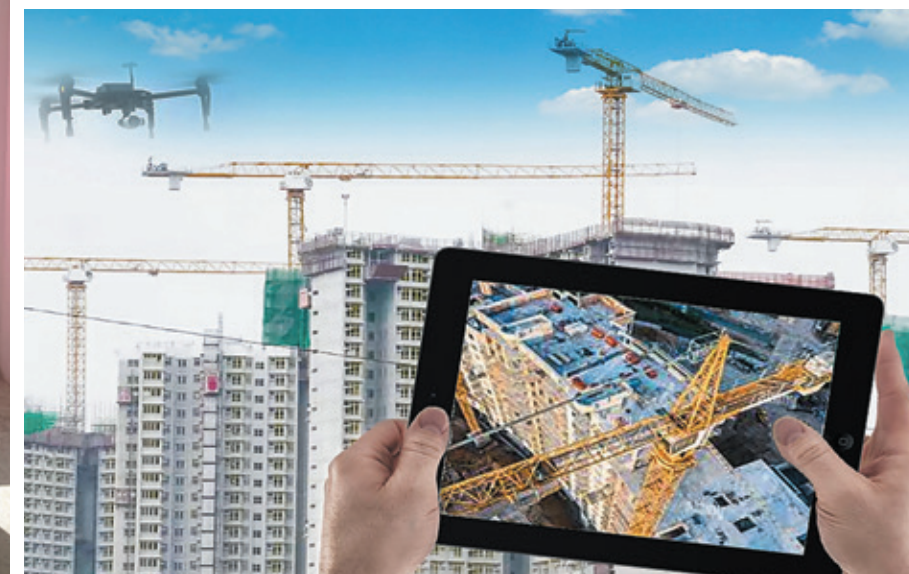
▲无人机结合人工智能检查新建楼宇外墙
